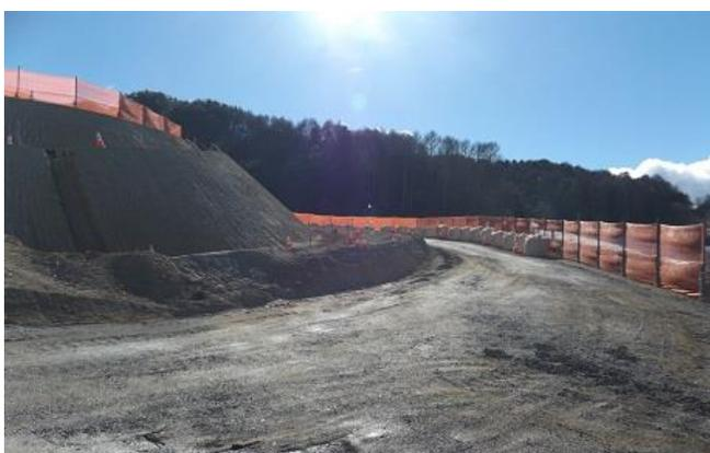
①進入道路部の掘削が始まり道路の形が見えてきました。さらに4～5m下へ掘削する計画です。
