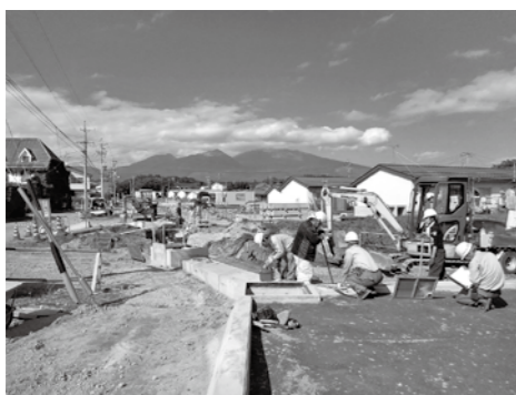
工事中の児玉荒町線
