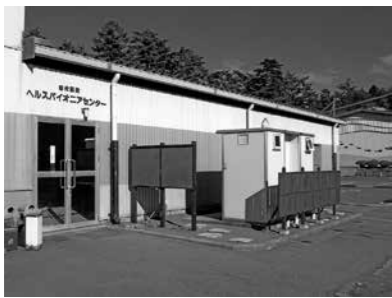
ヘルスパイオニアセンターのトイレ
