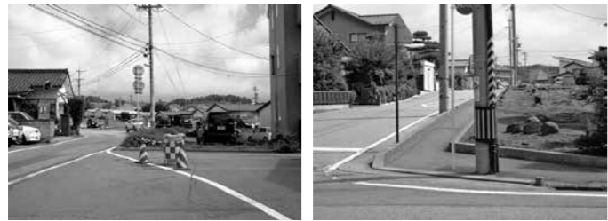
整備が進む児玉荒町線と上小田井雪窓線
