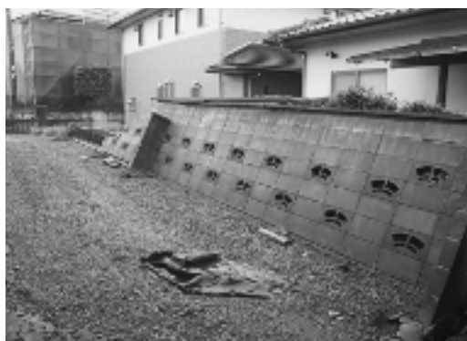
現行基準に適合せず倒壊したブロック塀
