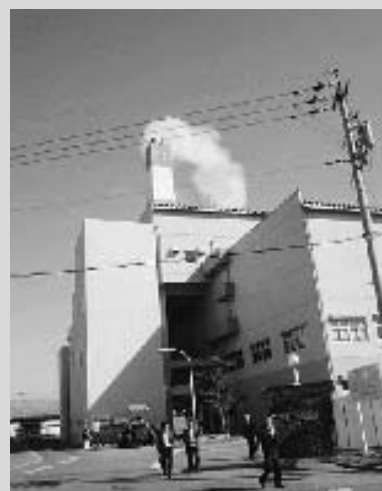
現在稼働している旧施設を見学
