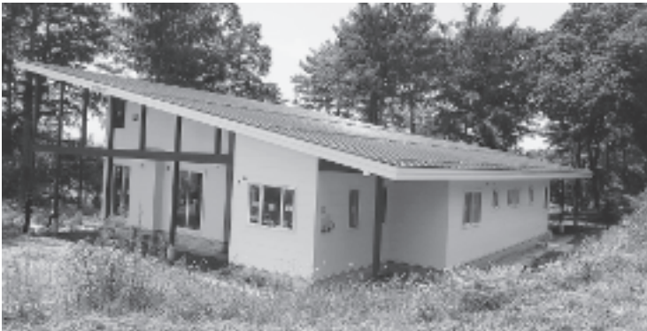
新園舎建設中(10月初旬に完成予定)
