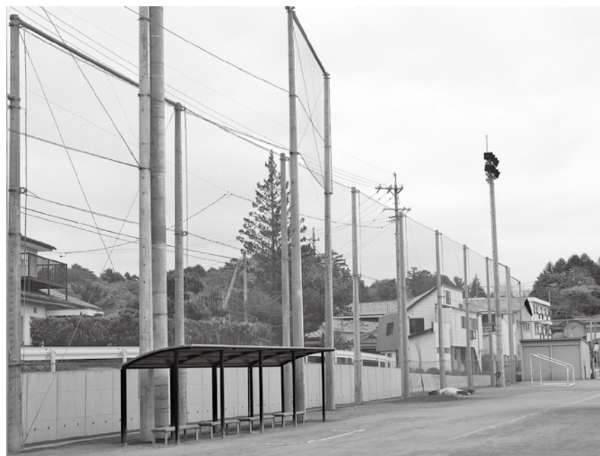
改修予定の防球ネット
