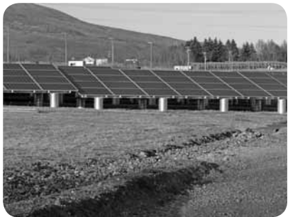
太陽光発電施設
