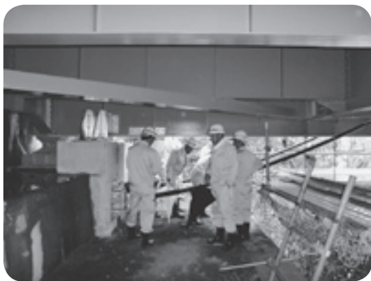
軽井沢大橋の耐震補強工事（委員会視察）
