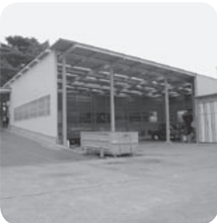
井戸沢処分場
